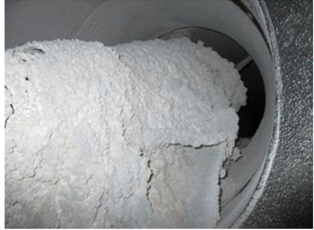
写真-2 白煙防止予熱器下部ヘッダー、ダクト内部苛性ソーダ堆積状況写真(改良前)
