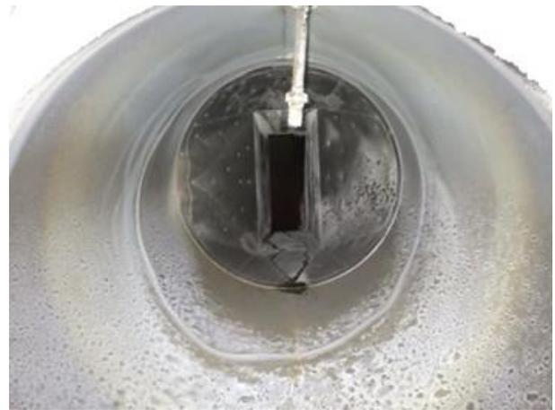
写真-3 白煙防止予熱器下部ヘッダー、ダクト内部苛性ソーダ堆積状況写真(改良後)
