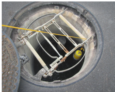
写真-4 硫化水素測定器の設置状況
