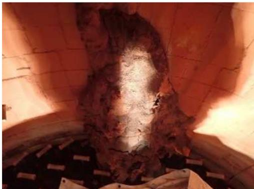
写真-3 焼却炉内クリンカ
