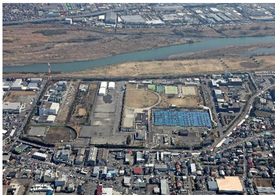
四之宮水再生センター（全景）
